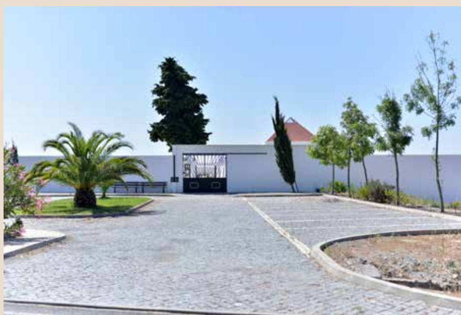
Obras de requalificação no cemitério de Casével
